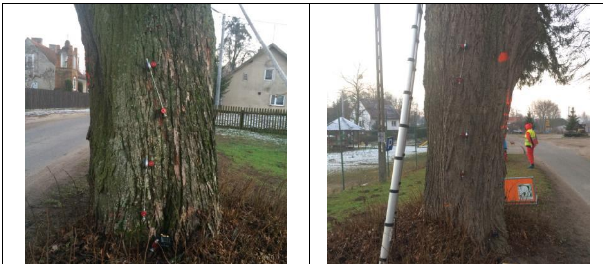
Fot. 5-4. i 5-5. Lipa nr 4/13 w trakcie badania metodą obciążeniową. Miejsce montażu czujników
