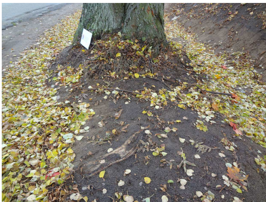
Fot. 21 Uszkodzone korzenie drzewa przez prace wykonane z użyciem ciężkiego sprzętu.
